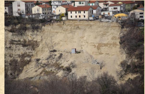
Panoramica della Frana di Campli
